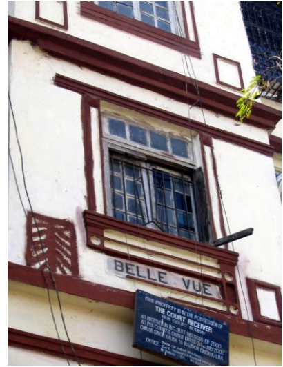
Simple motifs on the façade
